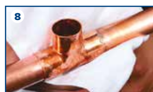
8 Giunzione completata
